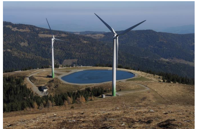
Die Wasserfassung zur Beschneigung mit den beiden Windrädern am Hahnsattel (1713 m).
